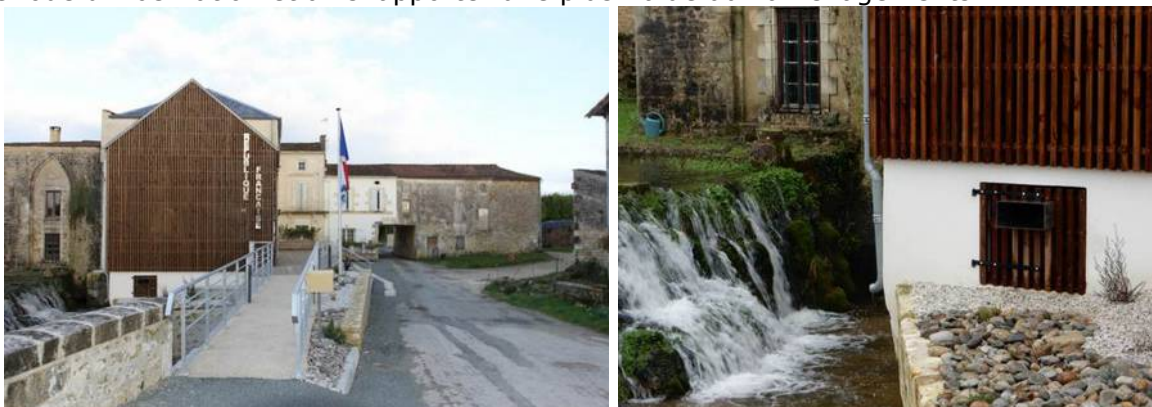
Figure 6 : Vues de profil de la mairie avec trappe d'accès au sous-sol (2016).
