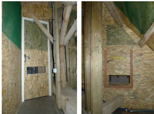
Figure 5 : Vues intérieures de la partie isolée à l'Est des combles, porte d'accès à gauche, trappe donnant au-dessus du bief à droite et vue des grillages plastiques à mailles fines permettant l'accroche des animaux sur les parois. (2016).
