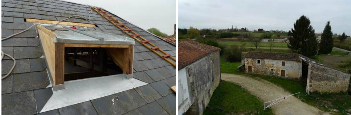
Figure 2 : Chiroptière créée dans la toiture et vue de la cour depuis la chiroptière (2015).
