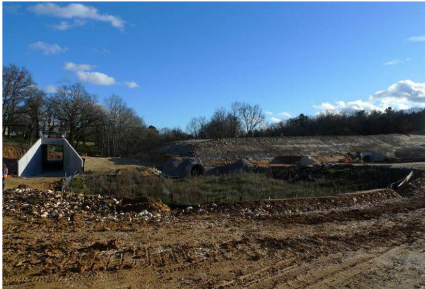
Chantier de la LGV à Montguyon
