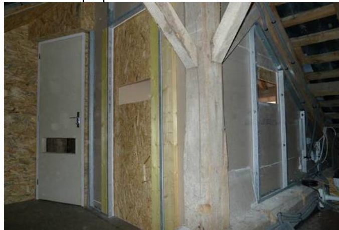
Figure 3 : Sas d'entrée et ouvertures créées dans les portes ou les cloisons permettant la circulation des chauves-souris dans les combles, à gauche sur la photo, porte accédant à la partie isolée (2016).
