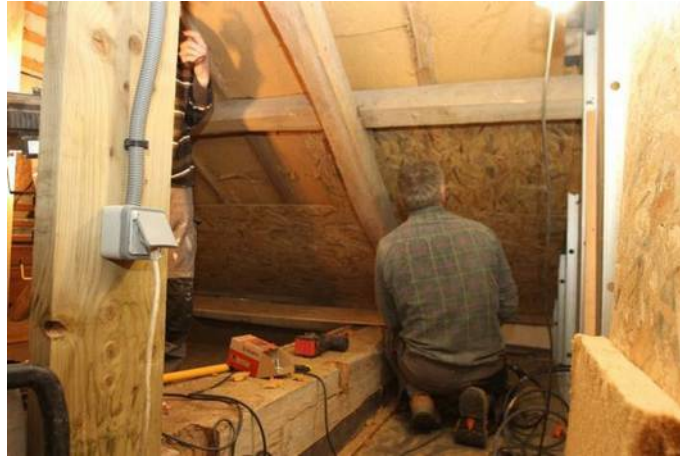
Figure 4 : Travaux d'isolation de la partie Est des combles (2016).
